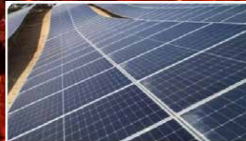
Macroparque fotovoltaico. Invertia
